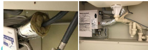
(給湯配管の保温工事)
